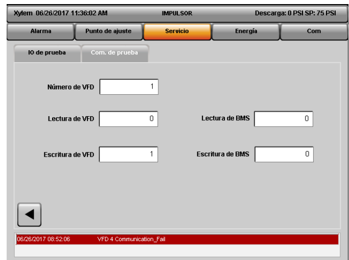
Figura 5.5.36: Comunicación de prueba (VFD y BMS)
